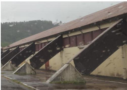
Die Dachkonstruktion besteht aus Holz mit Isolierter Blechverkleidung.
