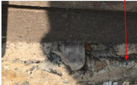
**Verdachtsmoment: polyzyklische aromatische Kohlenwasserstoffe PAK + Asbest/KMF****Probe 12: Außenverkleidung Marktbereich alte KMF mit schwarzer Feuchtigkeitssperre hinter Probe 11 auf Holzverkleidung (innen)**
