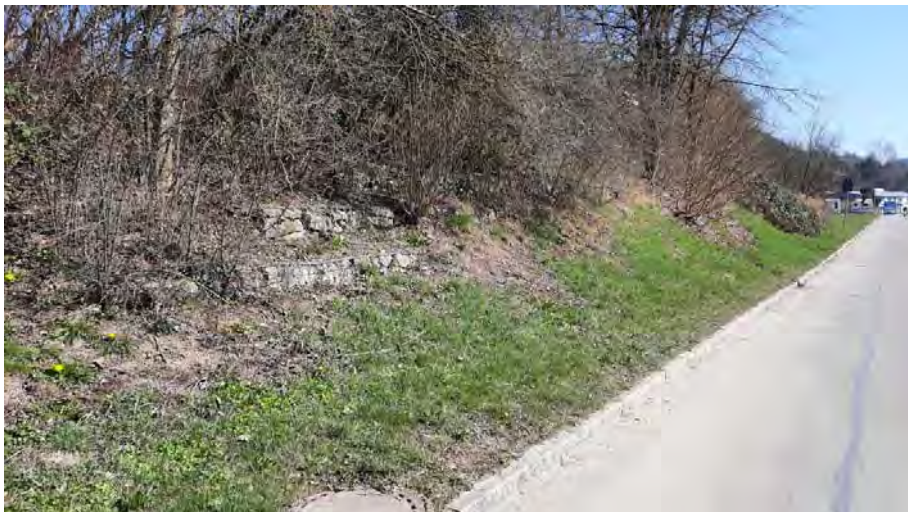
Abb. 13: Gabionen an der „Wilhelm-Soehle-Straße“
